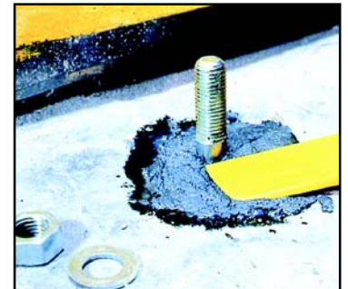
AFIANZAMIENTO DE PERNOS DE ANCLAJE
