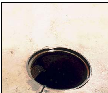
FOSAS PARA INSPECCION
