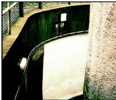
MUROS DE CONTENCION
