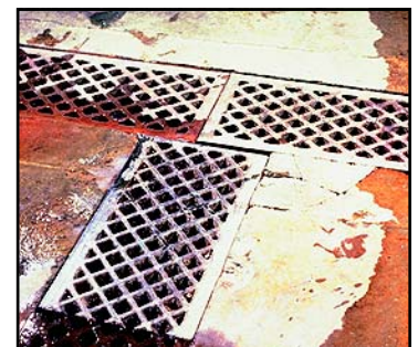
RECONSTRUCCIÓN DE CANALETAS
