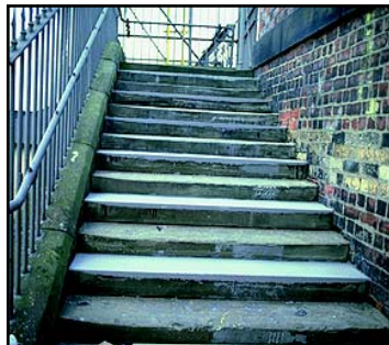
NIVELACIÓN DE ESCALONES
