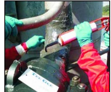
REPARACIÓN EN SITIO
