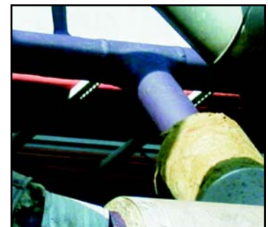
PROTECCIÓN DE TUBERÍAS
