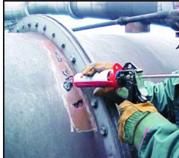
RELLENO DE PITTINGS POR CORROSIÓN
