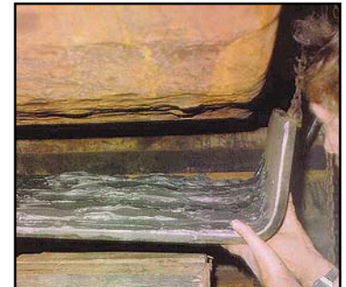
SELLAR PLACAS DE REFUERZO
