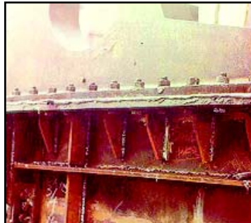
FORMAR LAMINILLAS DE SOPORTE DE CARGA
