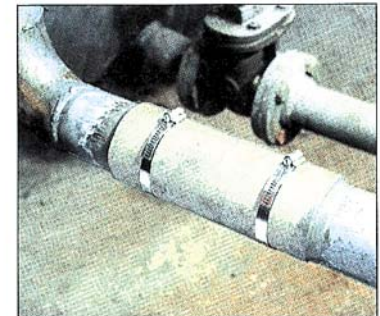
REPARACION DE TUBERIAS PERFORADAS
